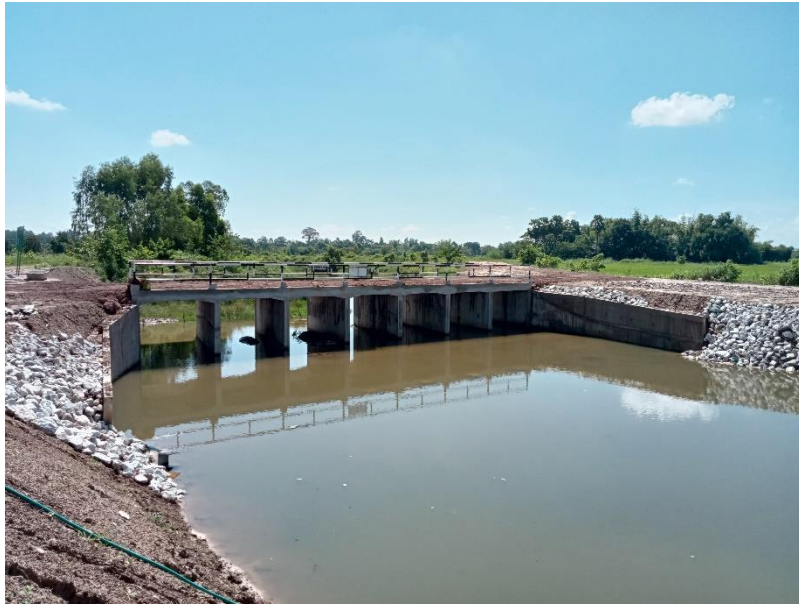
รูปถ่ายหลังดำเนินงานแล้วเสร็จ
